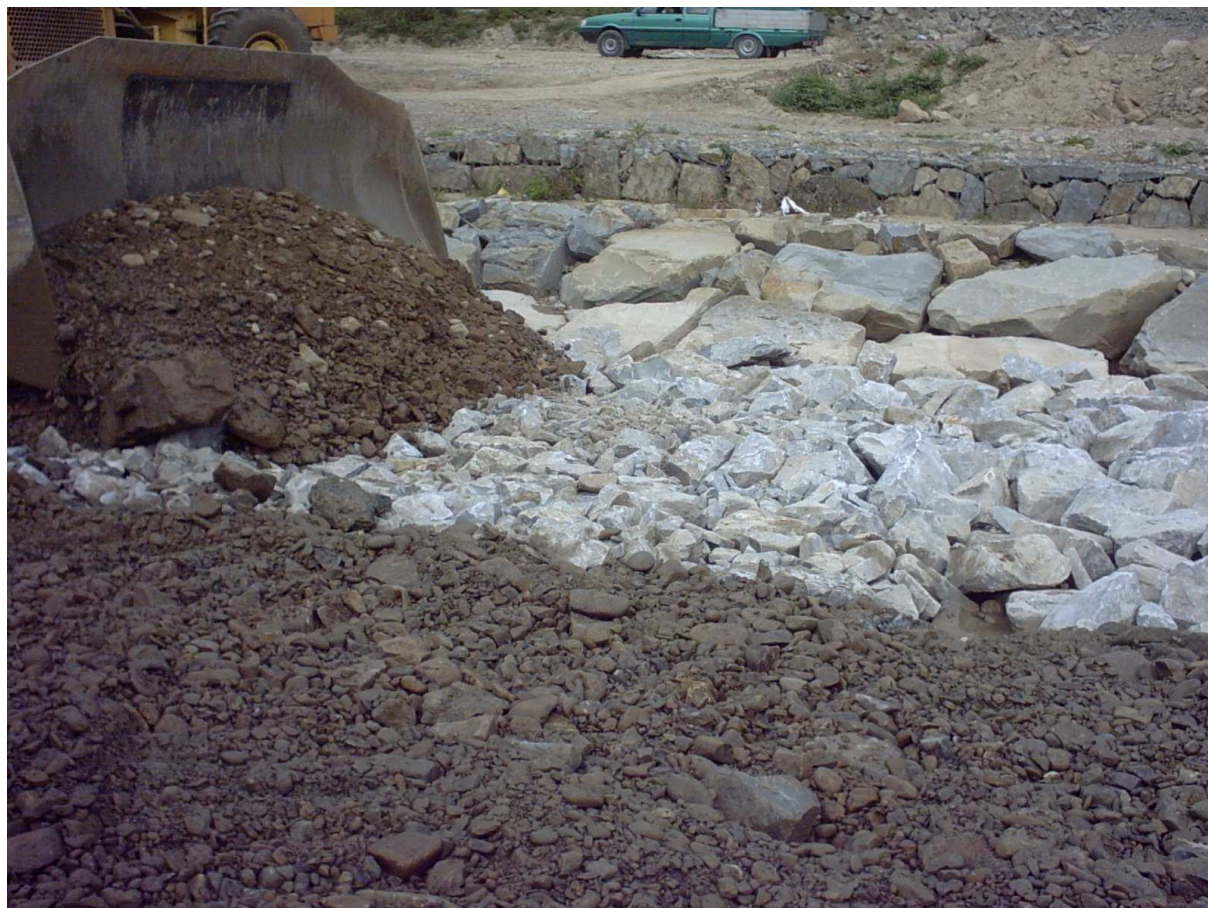
Klinowanie pospółką korony bystrza naturalnego, w którym wypełniono wybój rumoszem skalnym o uziarnieniu 200/400mm – przygotowanie do wałowania walcem drogowym.
