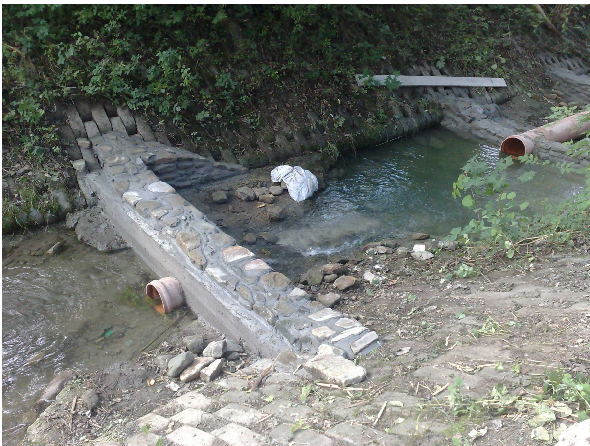
Potok Kobylok w Myślenicach: naprawa wyboju w betonowym dnie i równocześnie trasa powrotu do naturalnej części potoku dla ryb, gadów i płazów + częściowe przywrócenie aluwialnego charakteru dna potoku
